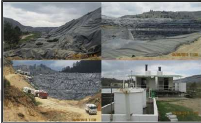
Fotografía 8. Celdas y Planta de Lixiviados Relleno Sanitario Nuevo Mondoñedo
