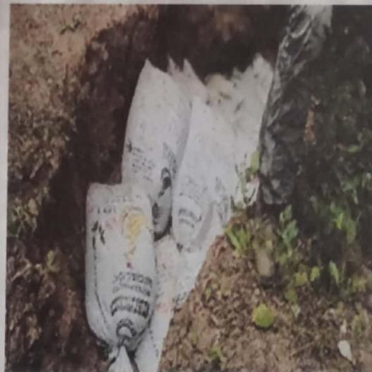
Foto 14. Se rellenó de lonas con arena sobre deslizamiento para evitar el agua sin infiltre.
