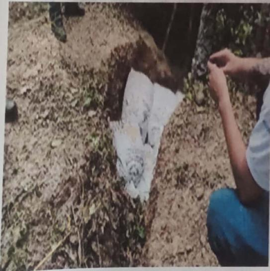
Foto 13. Se rellenó de lonas con arena sobre deslizamiento para evitar el agua sin infiltre.
