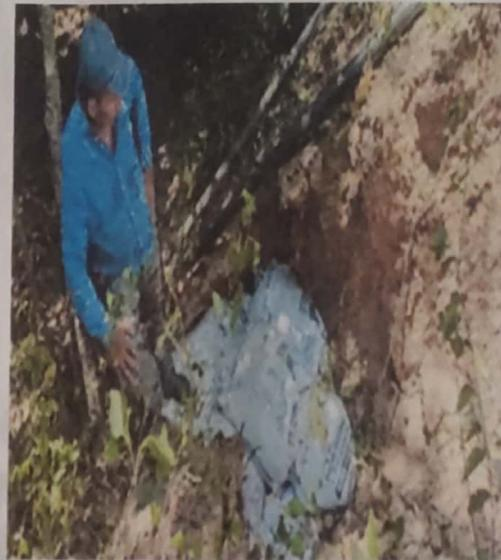
Foto 12. Se colocó las lonas con arena sobre deslizamiento para evitar que el agua sin infiltre.
