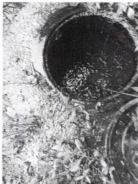
Img 2. Mantenimiento Pozo
