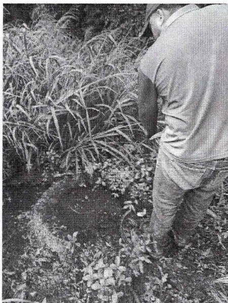
Img 1. Mantenimiento Pozo
