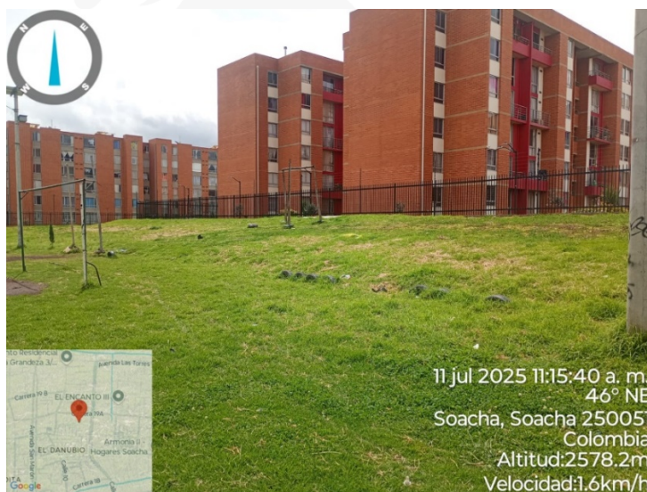
Imagen 4: Visita Técnica - Parque Villarosita
