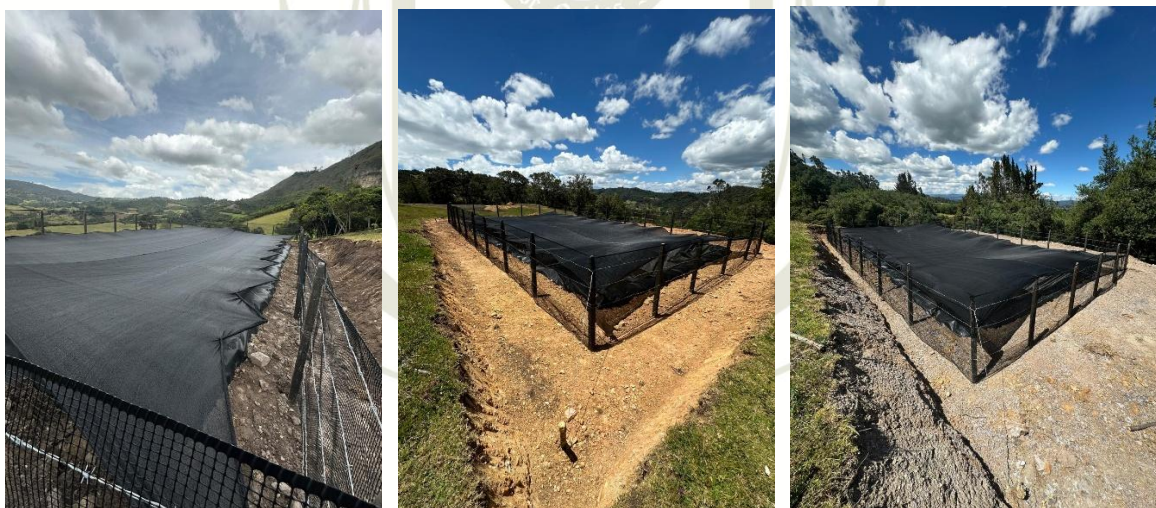
Imágenes 4, 5 y 6. Reservorios construidos.
