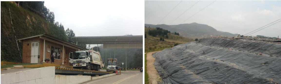
Figura X. Relleno Sanitario Nuevo Mondoñedo
