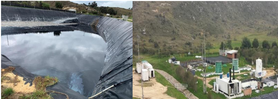
Figura X. Tratamiento de lixiviados
