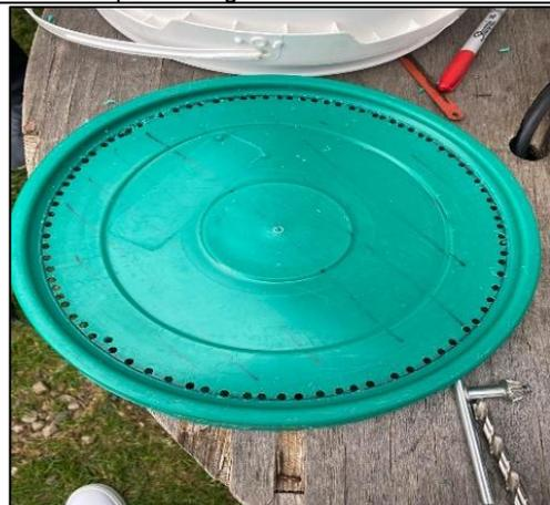
**Figura 13 y 14.** Utilizando la segueta se realiza el corte por toda la delimitación que ya presenta los orificios, dejando las tapas huecas.
