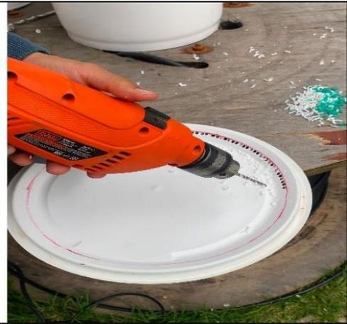
**Figura 10.** Con el taladro se realiza apertura de huecos sobre la delimitación de la tapa ya marcada, esto facilita el corte con segueta.
