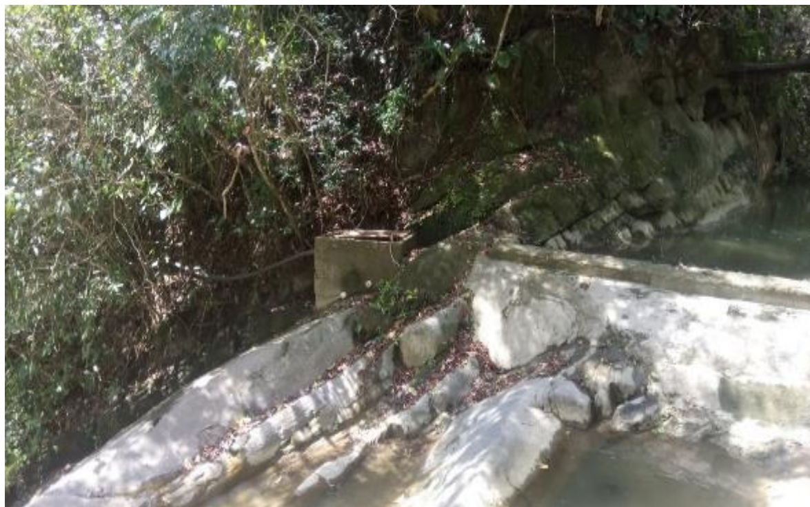
Fotografía 5-4 Bocatoma Quebrada La Berbería Cámara De Derivación Acueducto Veredal
