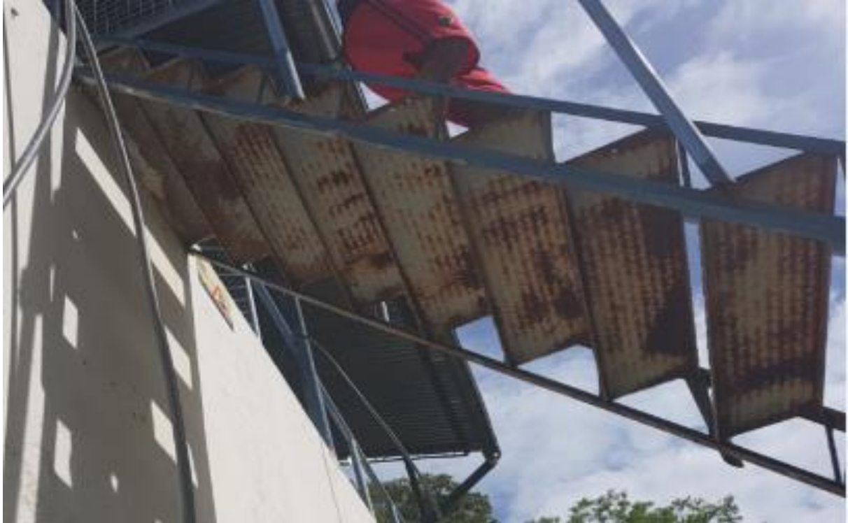
Fotografía 5-48 Oxidación Escalera De Planta A Tanque
