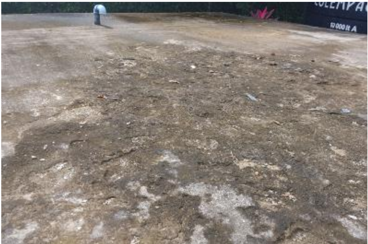
Fotografía 5-42 Empozamiento Y Daño En Impermeabilización Tanque N°2
