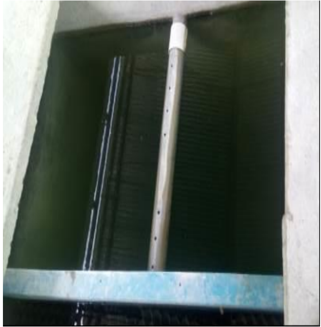
Fotografía 5-20 Detalle de sección de agua sedimentada
