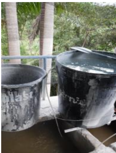
Fotografía 5-12 Tanques De Dosificación De Coagulantes
