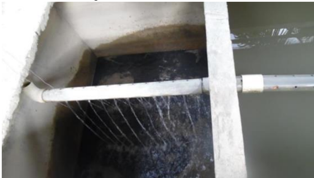
Fotografía 5-22 Detalle de filtro descendente
