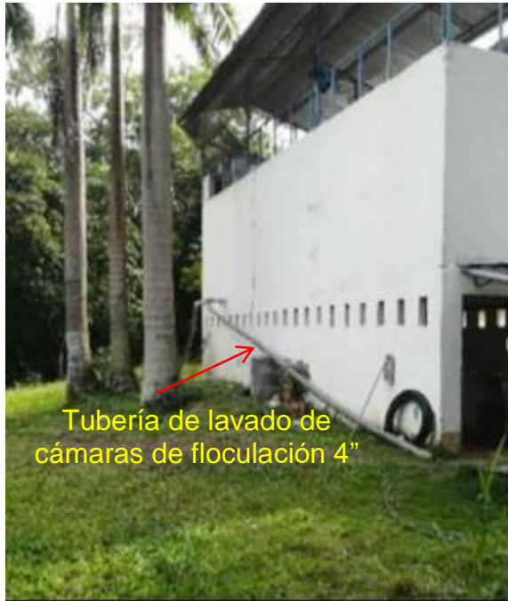
Fotografía 5-18 Detalle De Tubería De Lavado
