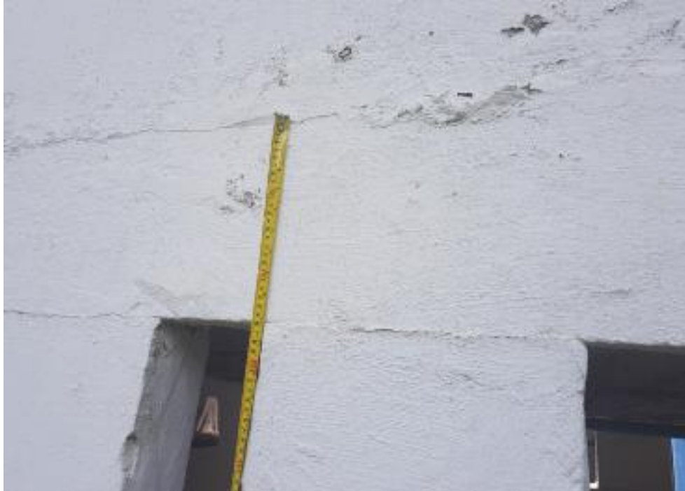
Fotografía 5-32 Espesor De La Losa De Segundo Nivel
