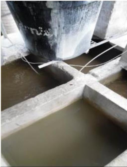
Fotografía 5-17 Detalle De Floculadores Tipo Alabama
