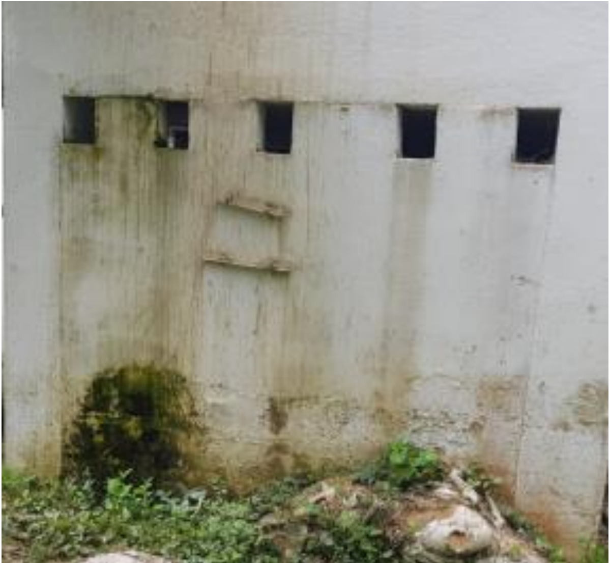
Fotografía 5-34 Materia Orgánica En Muro Posterior
