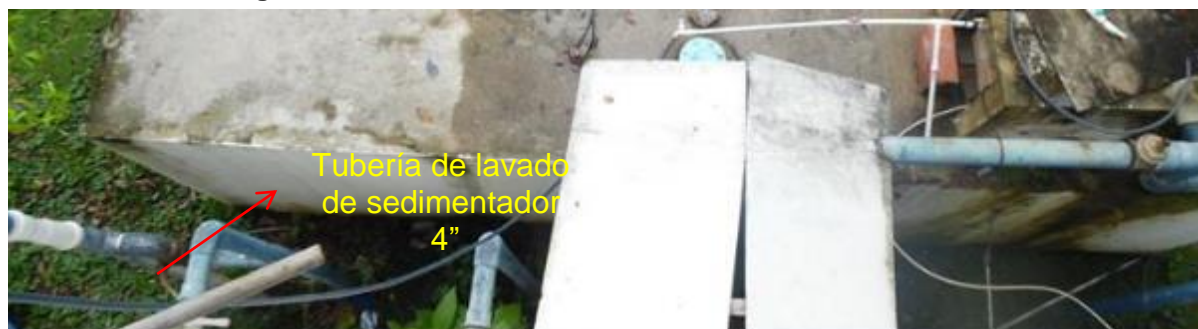
Fotografía 5-21 Detalle De Tuberías De Lavado Del Sedimentador
