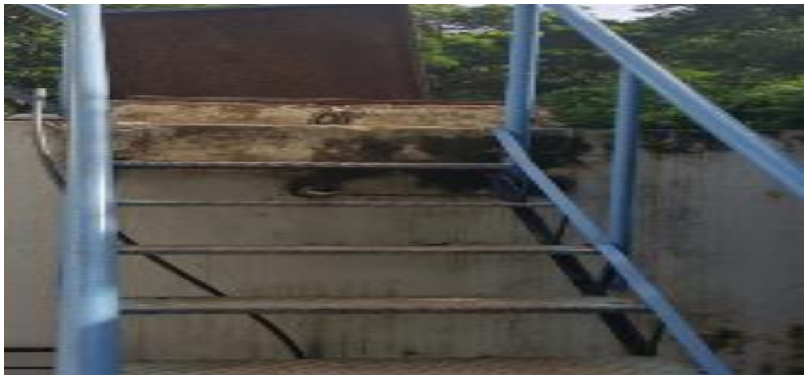
Fotografía 5-49 Oxidación Escalera Y Acceso A Tanque N°2
