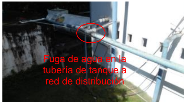
Fotografía 5-26 Detalle de sistema de tuberías de filtro
