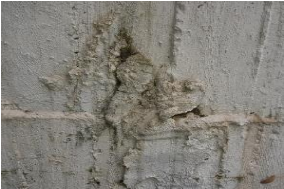
Fotografía 5-44 Zona Resanada Y Pintada Por Defectos De Fundida
