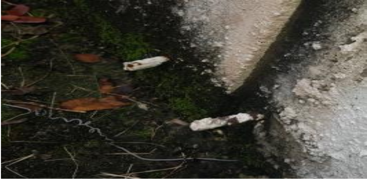
Fotografía 5-47 Aceros Expuestos En Tanques
