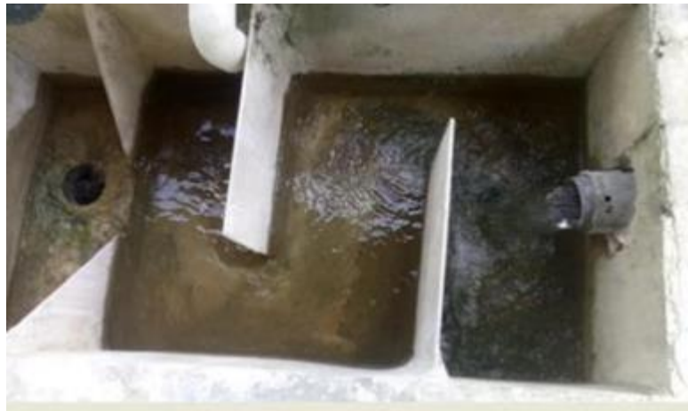
Fotografía 5-10 Vista General De Cámara De Mezcla Rápida
