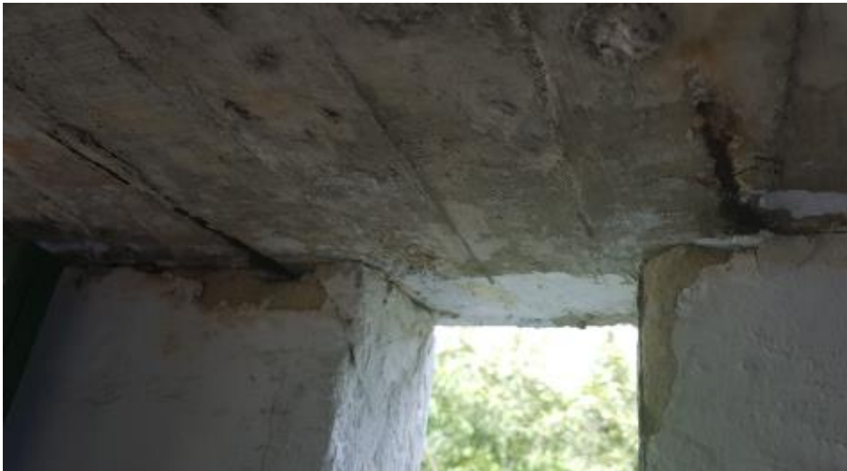
Fotografía 5-37 Afectación De Elementos No Estructurales Y Acero Expuesto
