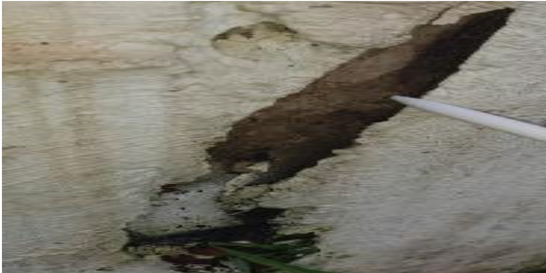
Fotografía 5-44 Zona Resanada Y Pintada Por Defectos De Fundida
