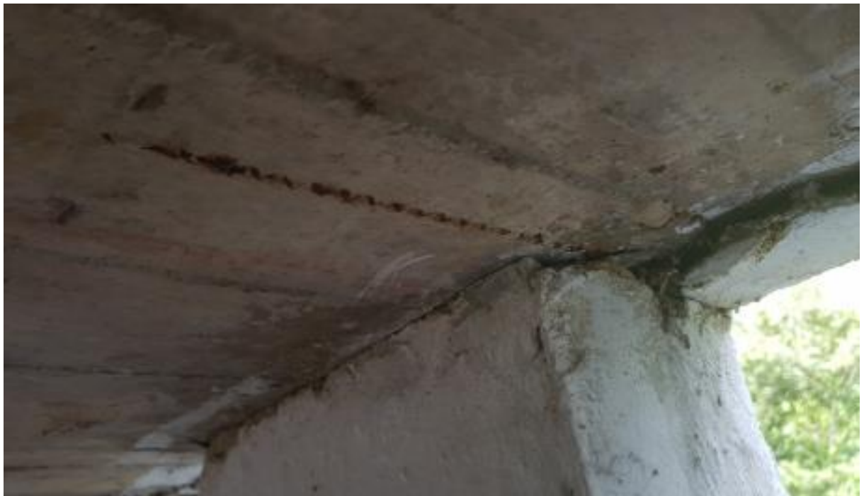
Fotografía 5-36 Aceros Expuestos En Losa De Entrepiso
