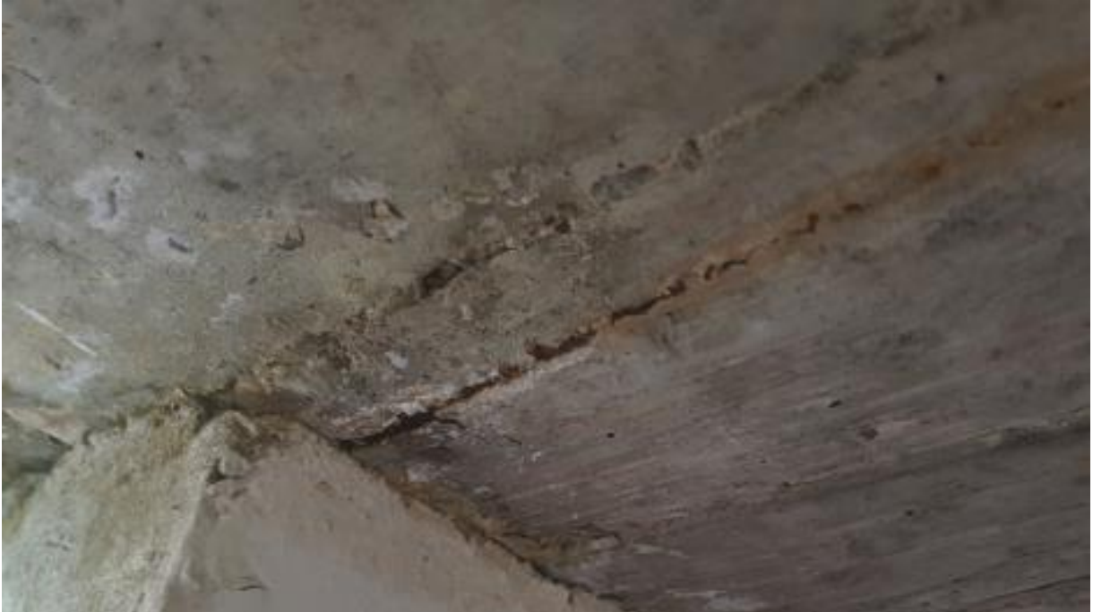
Fotografía 5-35 Aceros Expuestos En Losa De Entrepiso
