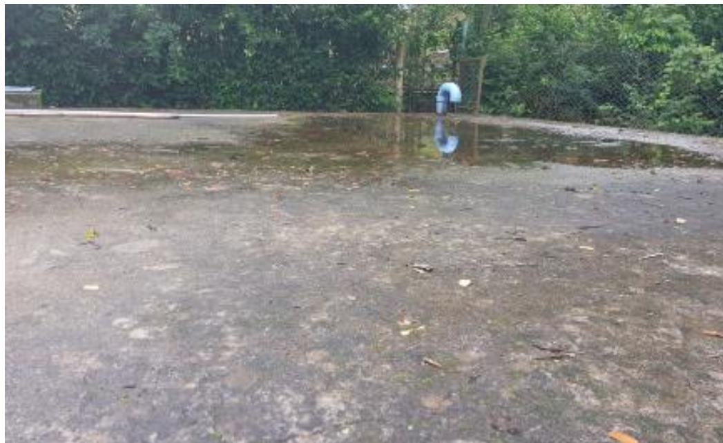
Fotografía 5-38 Empozamiento En Cubierta De Tanque N°1
