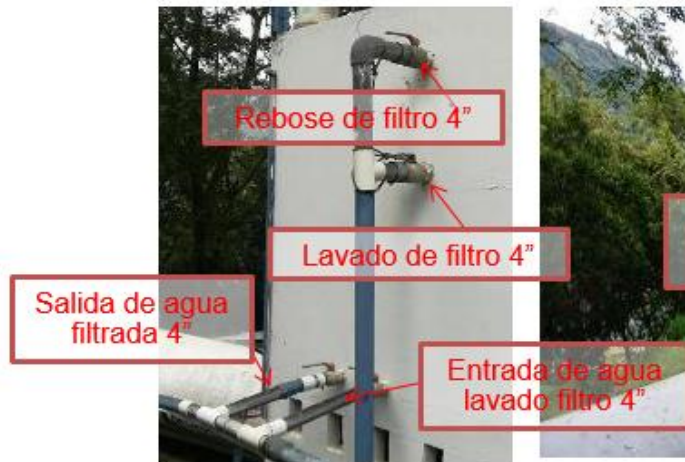
Fotografía 5-23 Detalle de filtro descendente
