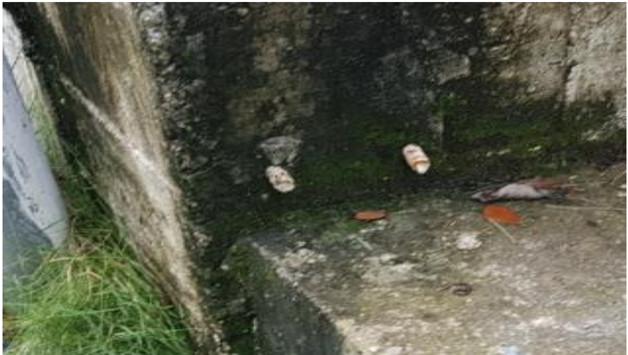
Fotografía 5-47 Aceros Expuestos En Tanques
