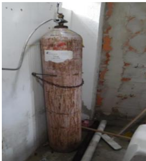
Fotografía 5-16 Detalle De Almacenamiento De Químicos Y Cloro Gaseoso
