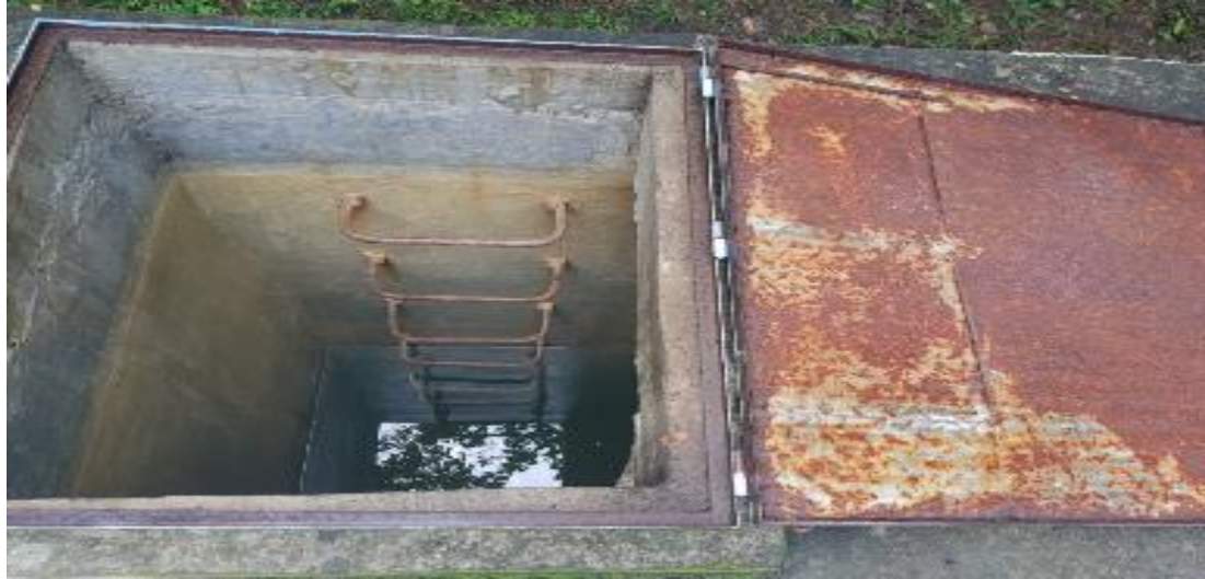
Fotografía 5-50 Oxidación Acceso A Tanque N°1
