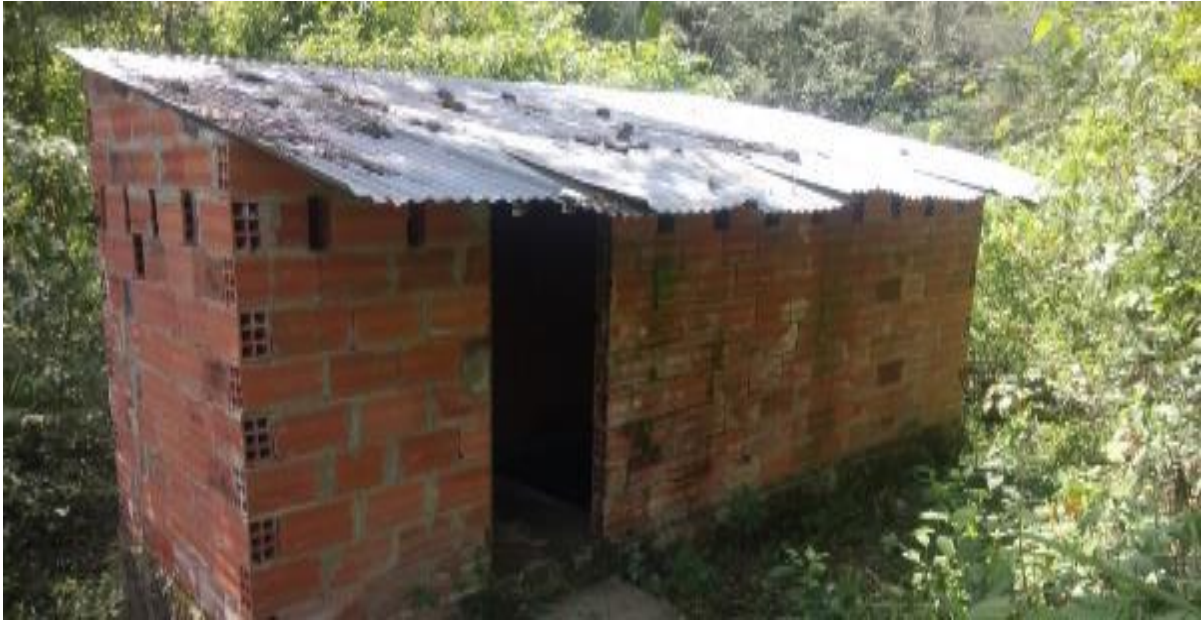
Fotografía 5-7 Cerramiento De Protección Desarenador
