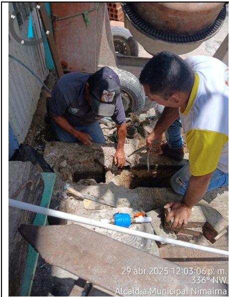
Ilustración 3: Se realizan los respectivos cambios de medidores para aquellos usuarios que su medidor no funciona.
