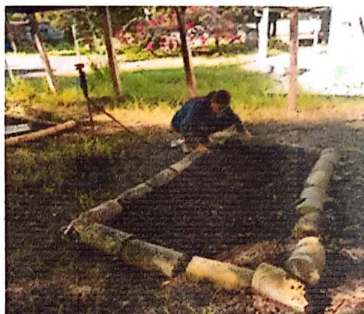
Foto 02. Se evidencia limpieza del terreno.
