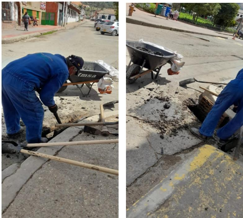
**Imágenes 7-8:** Mantenimiento manual de rejillas de la red de alcantarillado.
