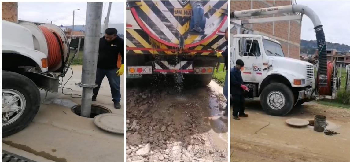
**Imágenes 1-6:** Limpieza y mantenimiento de la red de alcantarillado con vector.
