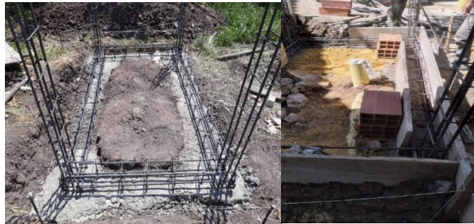
VIGA DE AMARRE CONCRETO 3500 PSI
