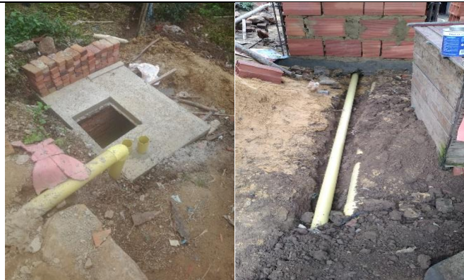
Muro en bloque No. 5 (E= 0.12)
