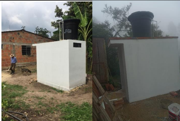
Suministro e instalación sanitario tanque (incluye grifería)
