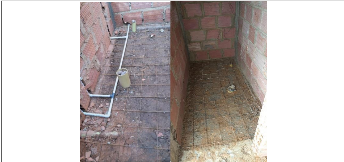
Placa base concreto 0.10 2500 psi
