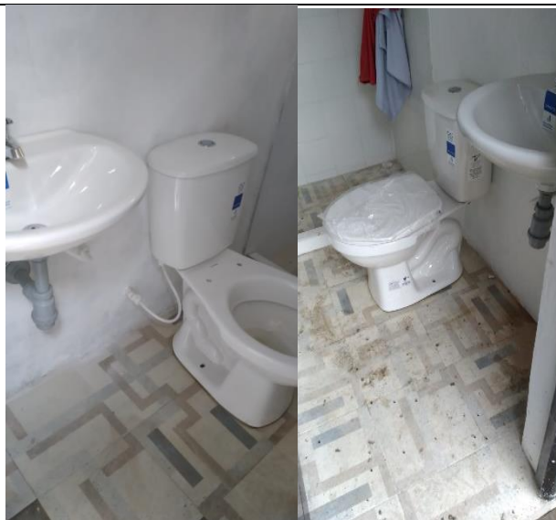
Suministro e instalación ducha sencilla
