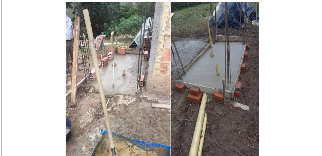
Alistado impermeabilizado pisos 1:3 (E= 0.04)
