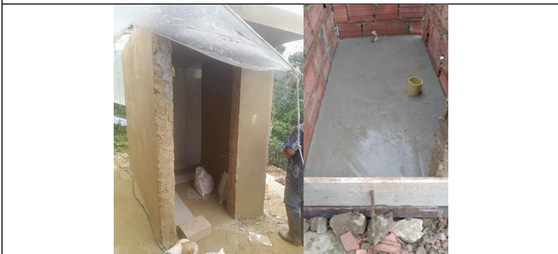
Alistado impermeabilizado pisos 1:3 (E= 0.04)
