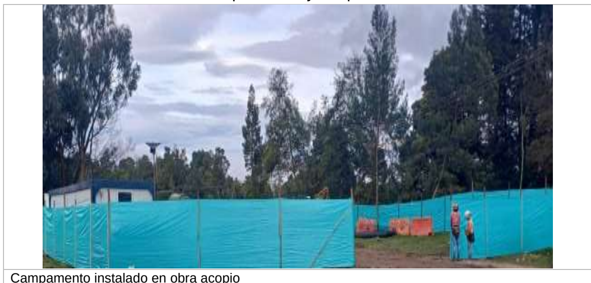
Ilustración 9. Instalación de campamentos y Acopio de materiales de obra
