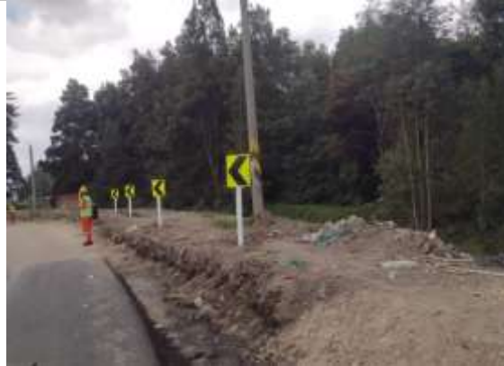
Instalación señalización vertical
