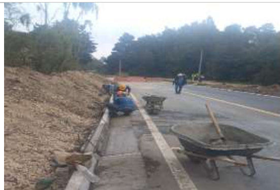
Construcción de cunetas
