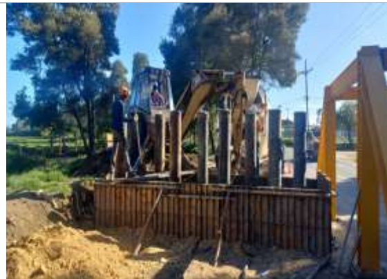
Construcción muro de contención
