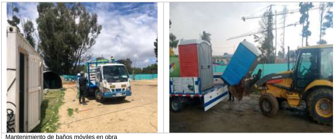
Mantenimiento de baños móviles en obra
