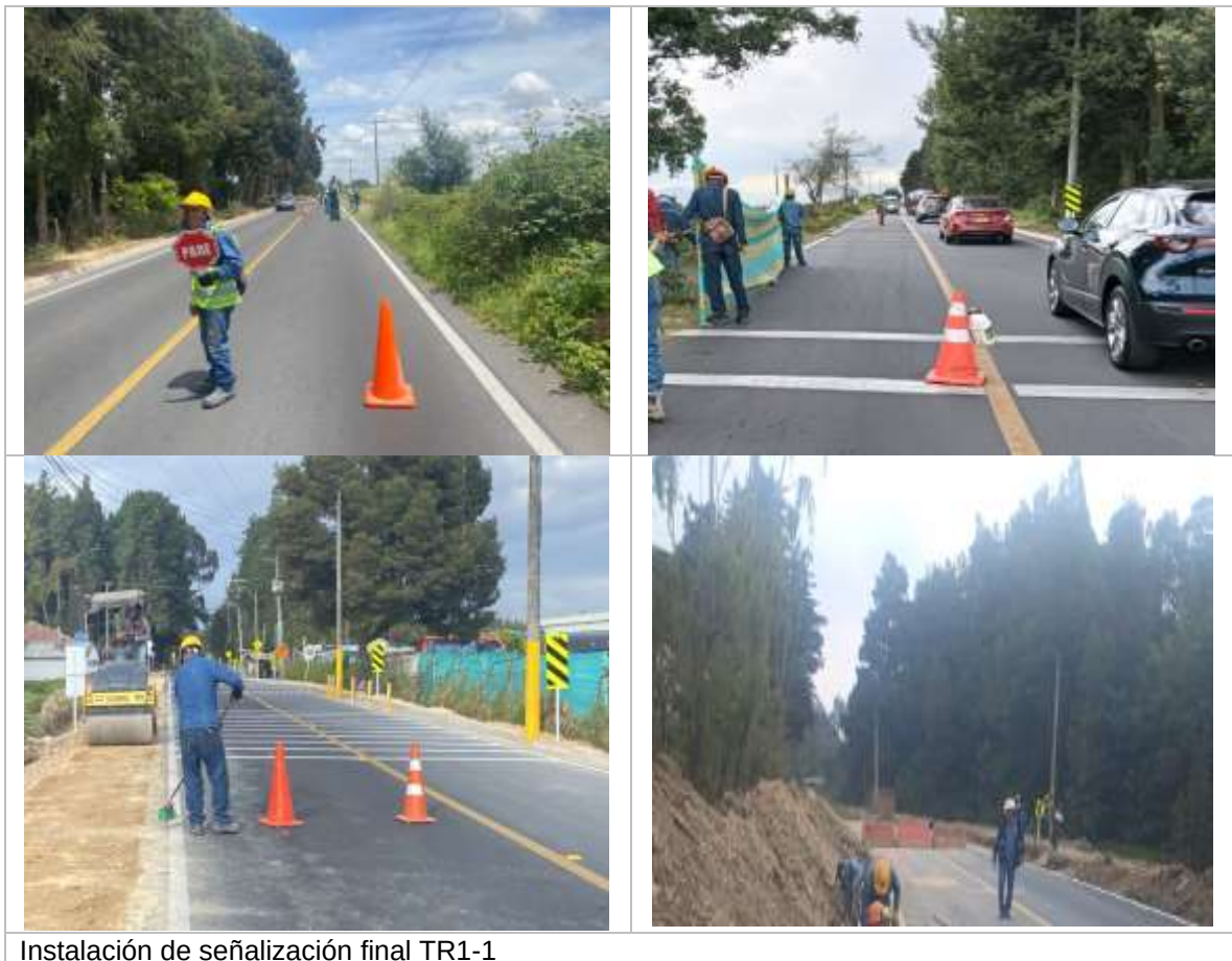
Ilustración 3. Señalización instalada en obra
