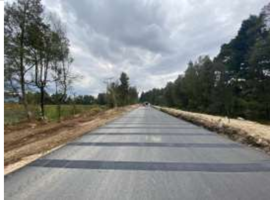
Imprimación señalización horizontal
