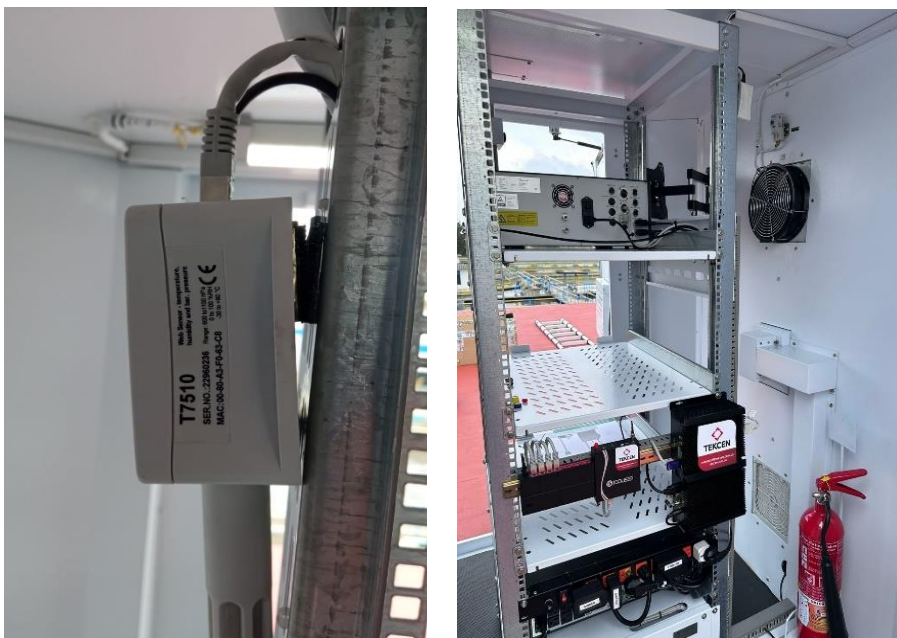
Ilustración 12. Instalación de cableado eléctrico, multitoma regulada, modem y datalogger.
