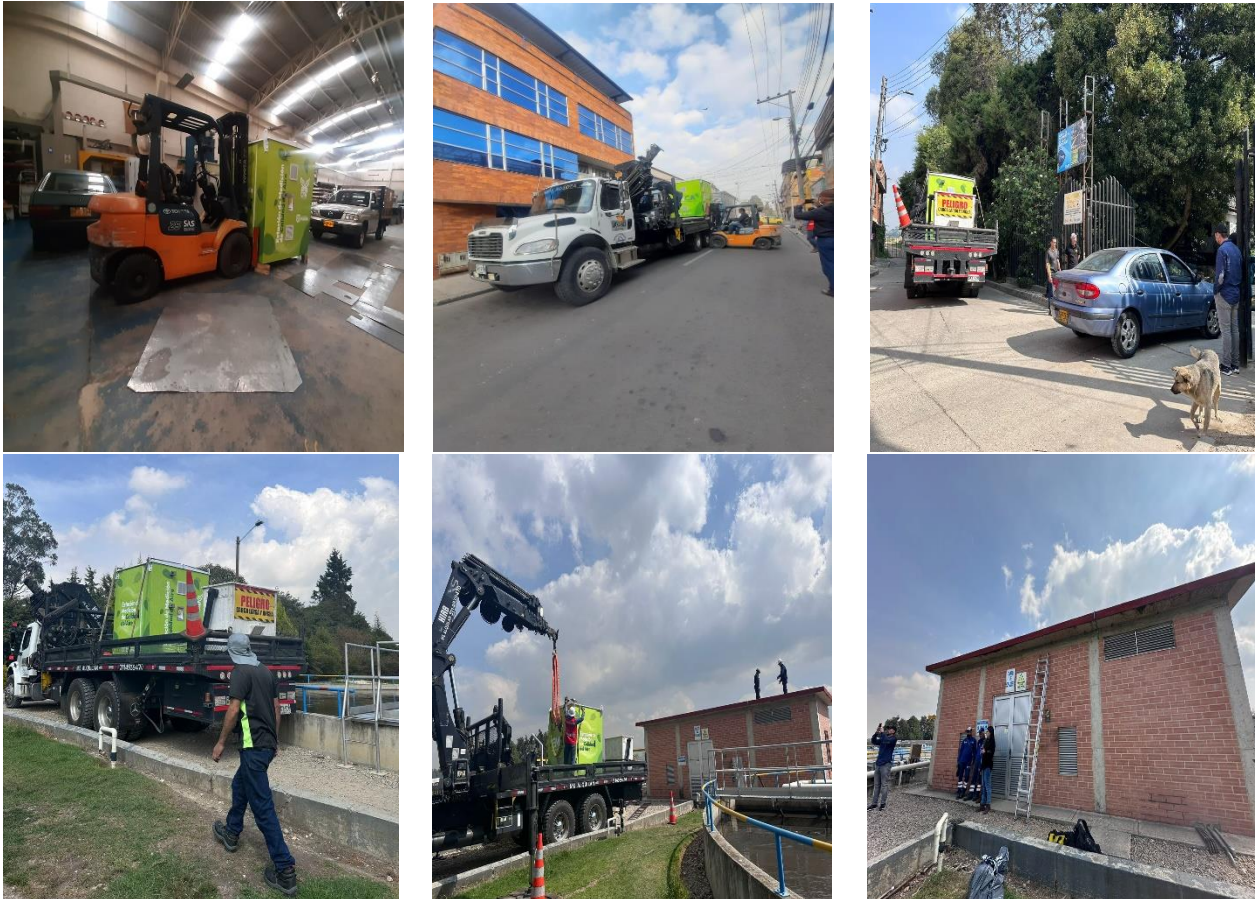
Ilustración 9. Desplazamiento de la cabina al punto de instalación.
