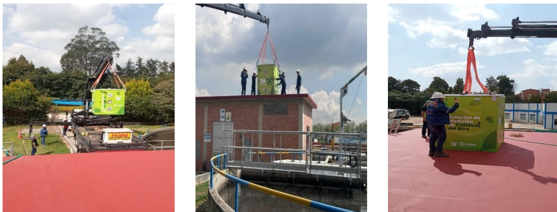
Ilustración 10. Izaje de la cabina.
