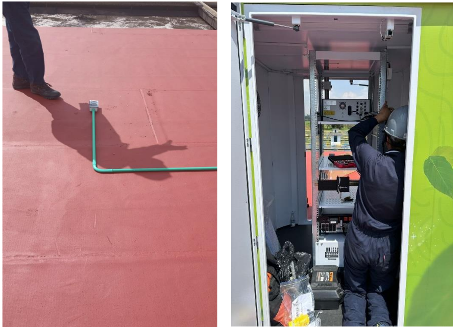
Ilustración 11. Instalación de equipo de material particulado Fidas 200 marca Palas.
