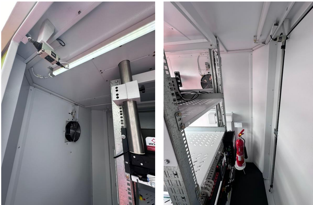
Ilustración 13. Instalación de canaletas y accesorios.
