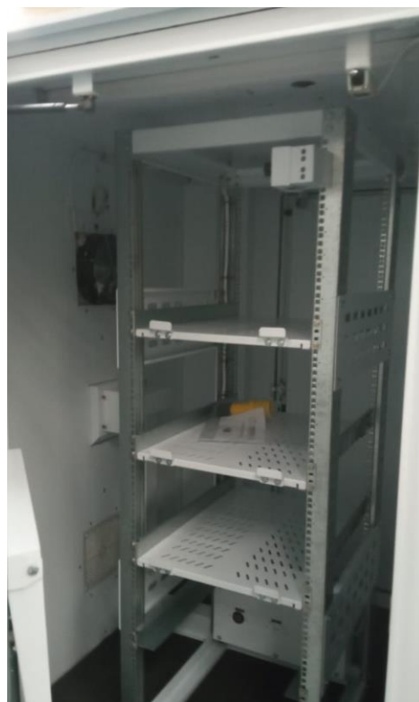
Ilustración 8. Instalación del rack, bandejas y sistema eléctrico.
