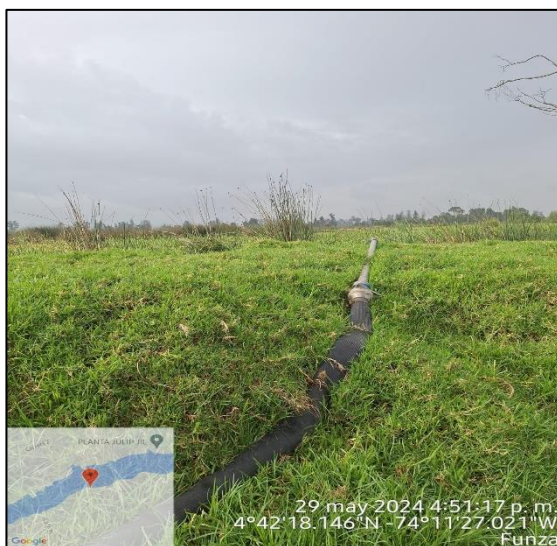
Ilustración 3. Tubería de conducción y descarga de aguas en el Humedal Gualí.
