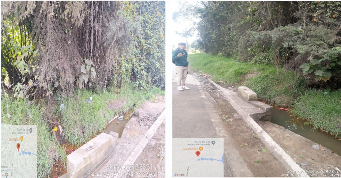
Ilustración No.4 Estado del canal al final del operativo
