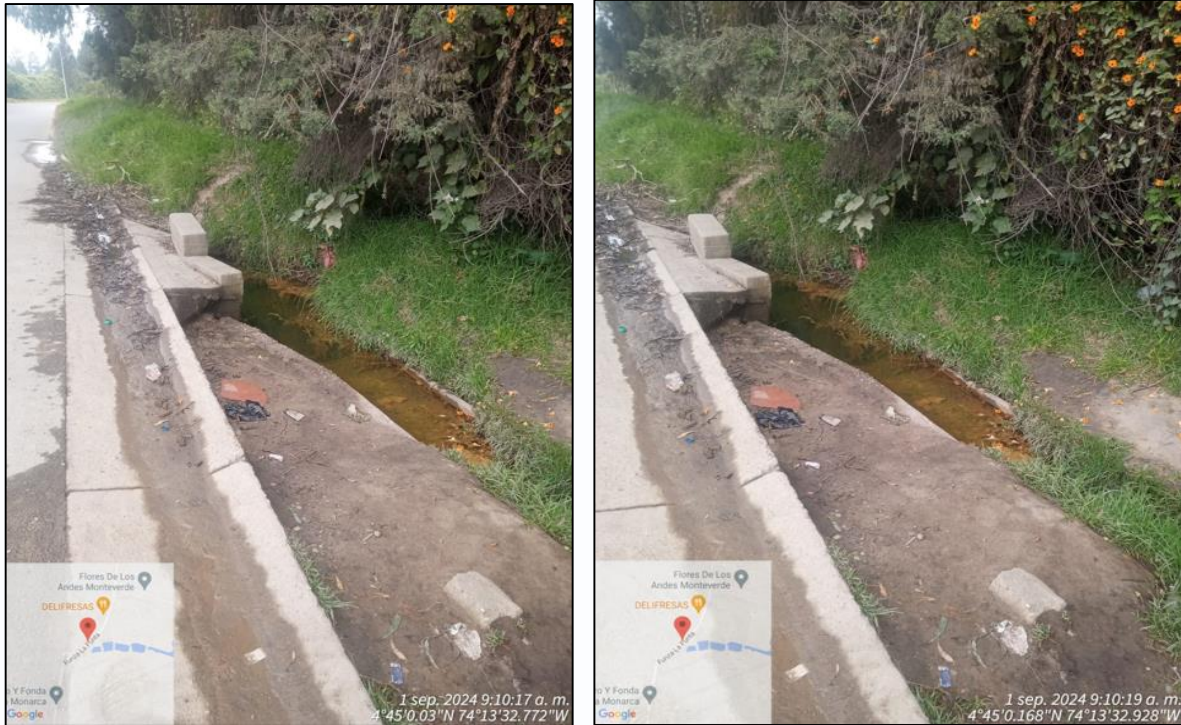
Ilustración No. 4 Canal sin presencia de vehículos
