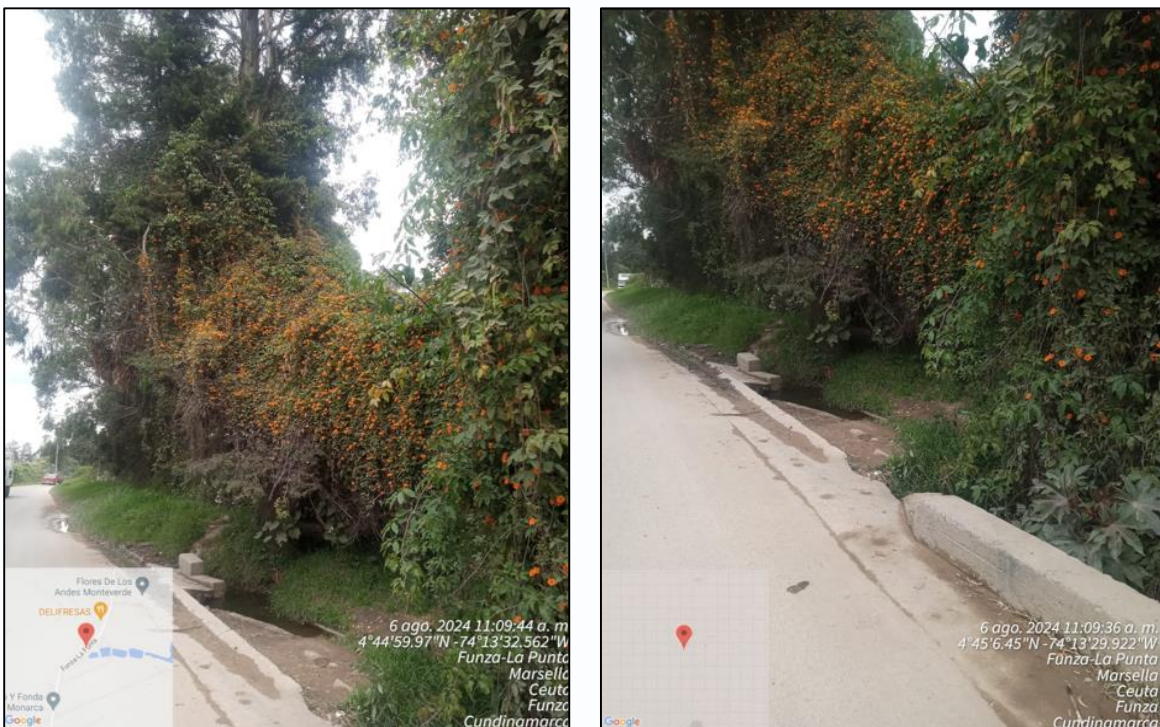
Ilustración No.3 Canal sin presencia de vehículos.
