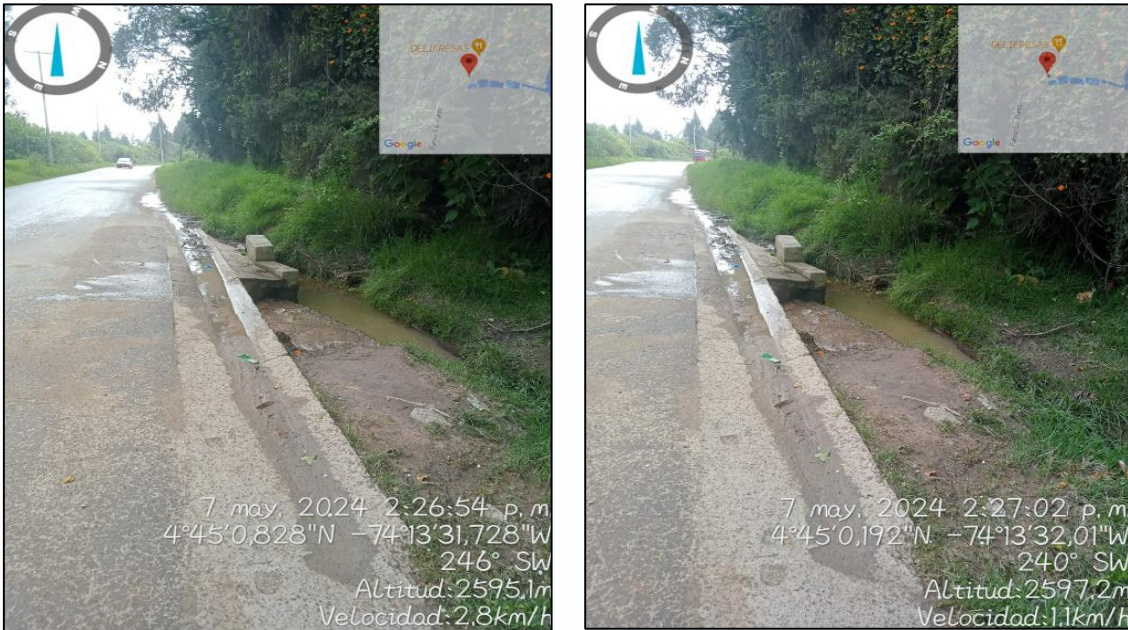
Ilustración No.3 Canal sin presencia de vehículos.
