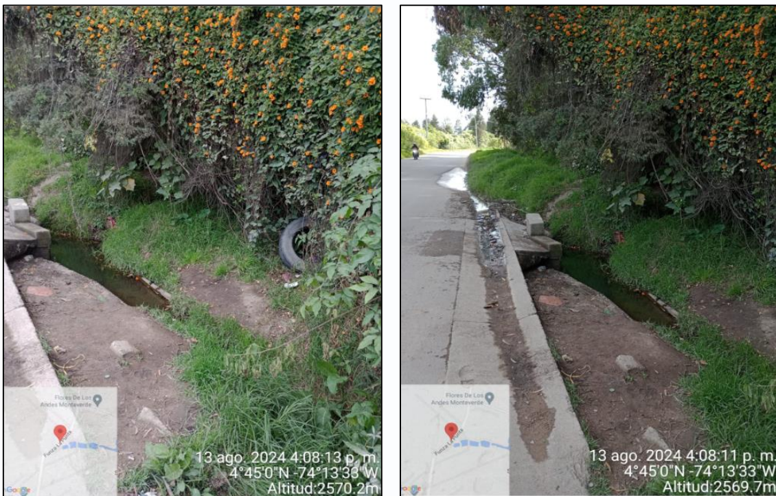
Ilustración No 4. Canal sin presencia de vehiculos.
