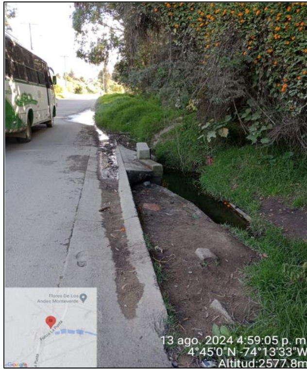
Ilustración No.5 Canal sin presencia de vehículos.
