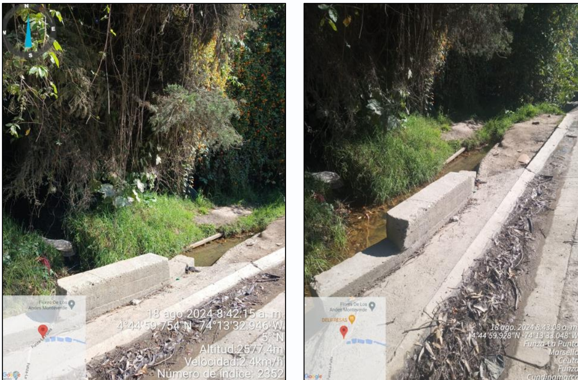
Ilustración No.3 Canal sin presencia de vehículos.
