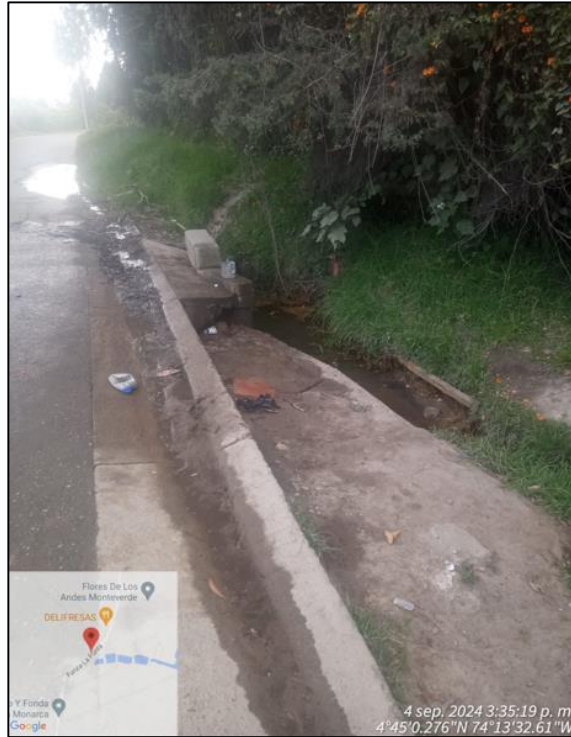
Ilustración No.2 Canal sin presencia de vehiculos.
