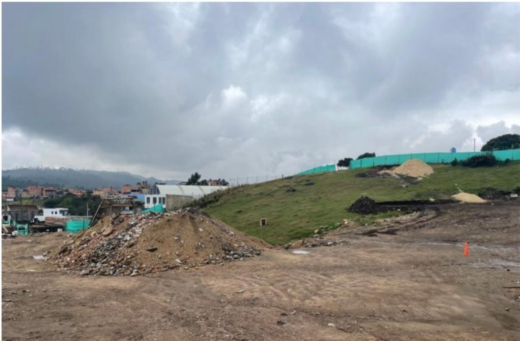
Fotografía 1. Evidencia I de actividades de gestión de RCD en Lote D. Fuente: Autor, 2023.
