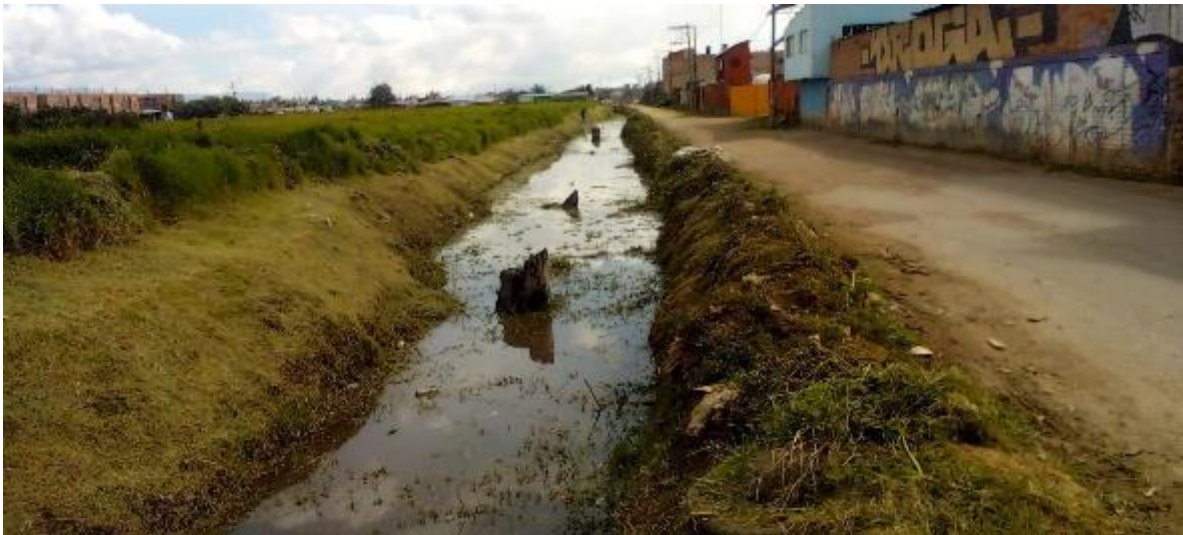
Fotografía 3. Estado de canal posterior al mantenimiento
