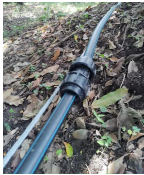
Instalación de uniones rápidas.
