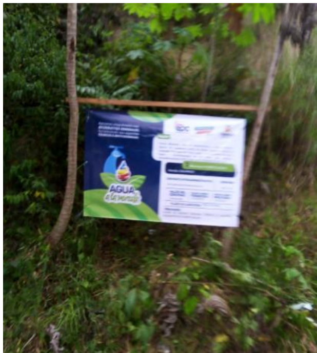
Instalación de la valla informativa.
