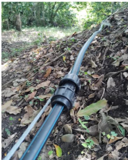
Instalación de manguera PF \frac{3}{4} "
