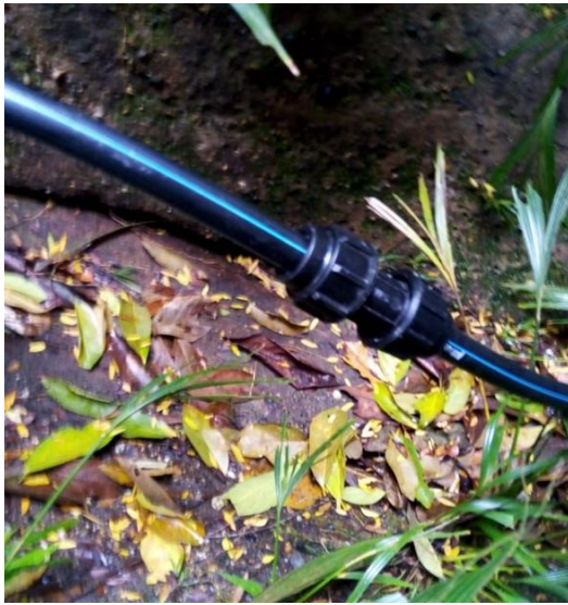
Instalación de uniones rápidas.
