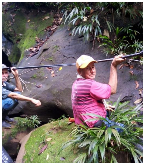
Instalación de manguera PF \frac{3}{4} "
