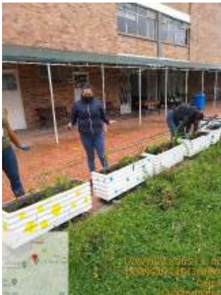
Fig. 3. Adecuación de materas y jardines
