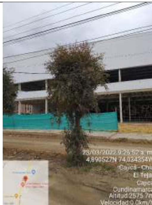
Fotografía 4. Árbol que interfiere con redes eléctricas y telefónicas
