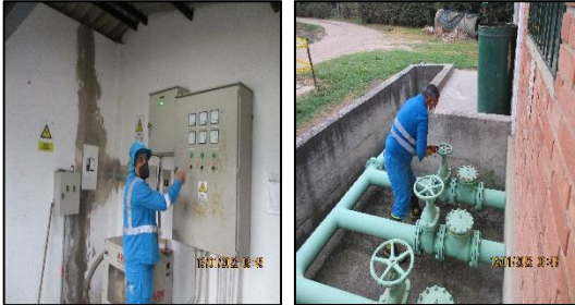
Fotografía 9. Actividades de operación y mantenimiento PTAR Calahorra
