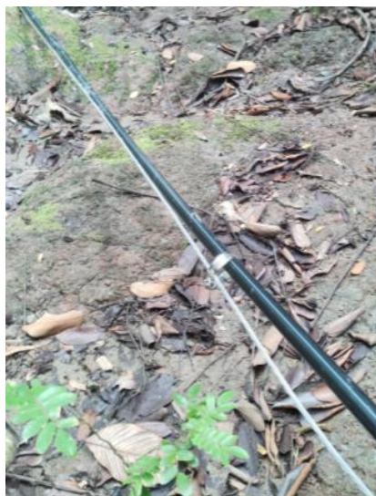
Instalación de abrazaderas galvanizadas
