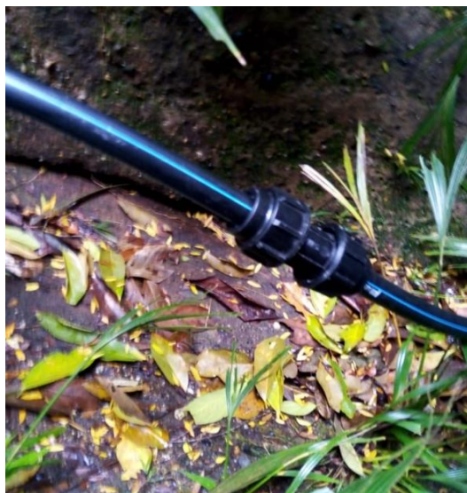
Instalación de uniones rápidas.
