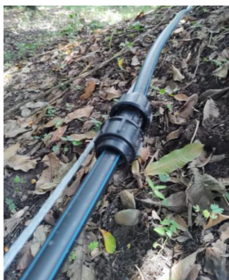
Instalación de uniones rápidas.
