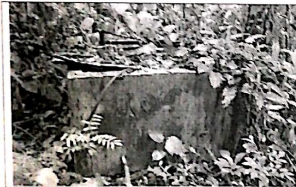
**Fotografía 3.** Tanque desarenador y de distribución de las aguas del nacimiento en el predio Villa Hermosa, área de protección ambiental entregado a la alcaldía municipal por compensación del 1%.
