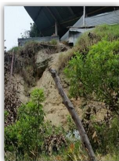
Imagen 1 Construcción en zonas de remoción en masa
