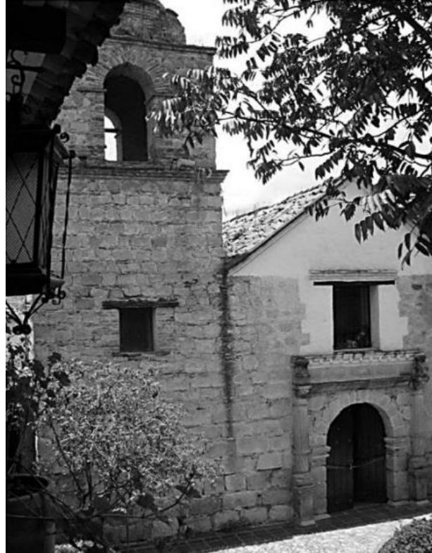
Fachada principal de la capilla
