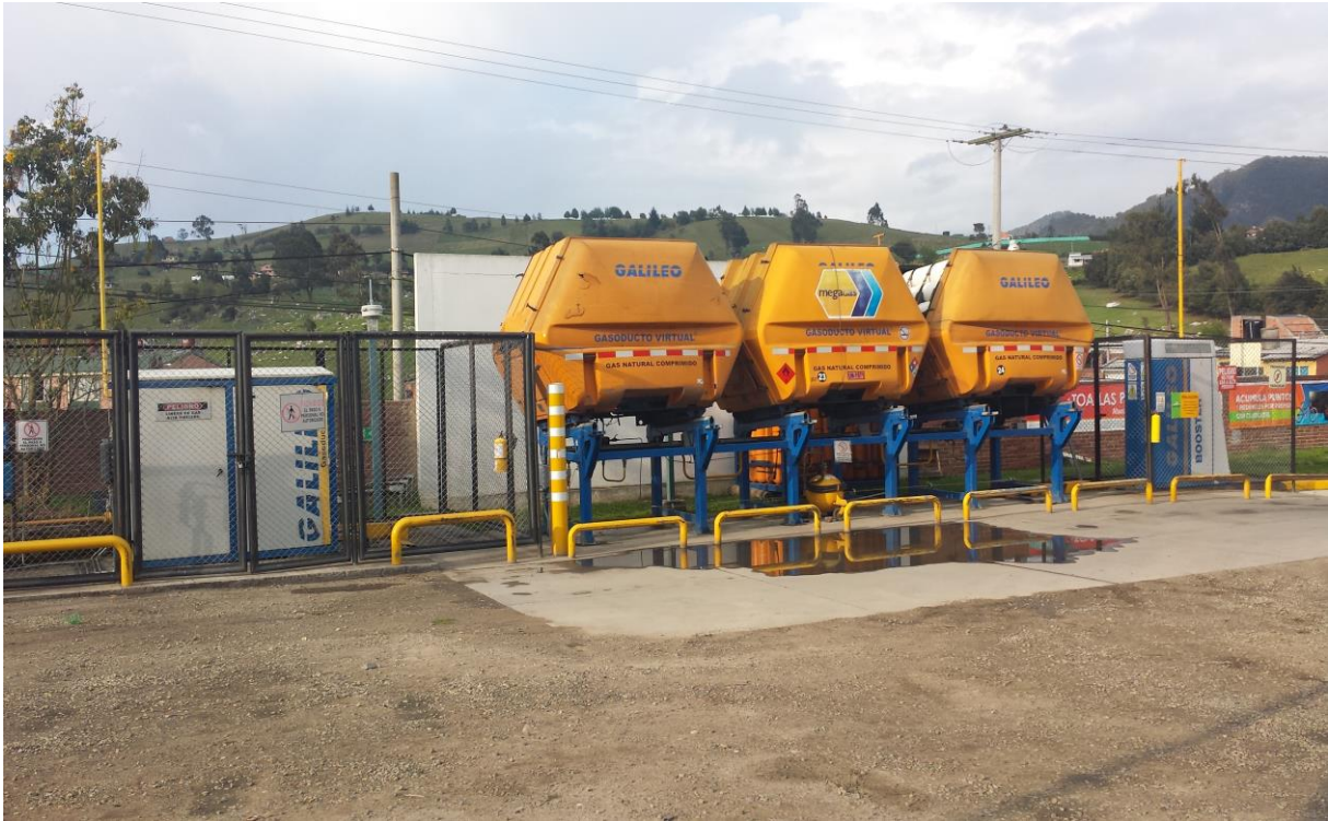
Fotografía: Gasoducto virtual La Calera- 2014
