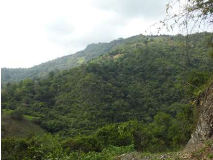
Ilustración 23. Afectaciones causadas al generar vías secundarias en zonas de alta pendiente y suelos de poca estabilidad estructural en Bituima.
