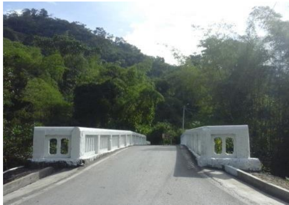
Ilustración 27. Puente de Guanacas
