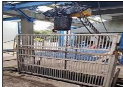
Ilustración 12. Canastilla de cribado
