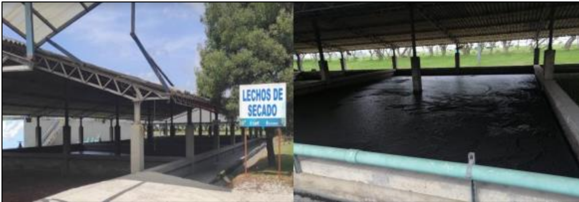
Ilustración 20. Lechos de secado
