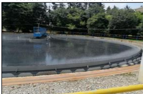
Ilustración 18. Sedimentador secundario
