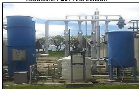
Ilustración 19. Hidrociclón
