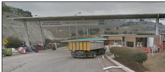
Ilustración 21. Relleno sanitario Nuevo Mondoñedo
