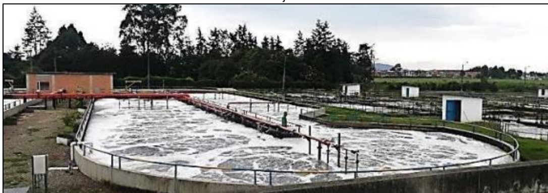
Ilustración 16. Zanjón sistema SBR
