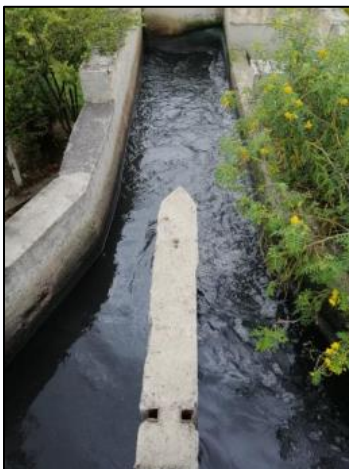
Ilustración 15. Desarenador
