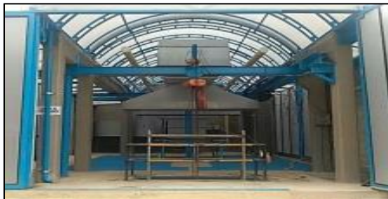
Ilustración 11. Pozo de homogenización
